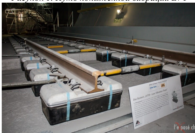
Рисунок 1. Путь пониженной вибрации LVT
